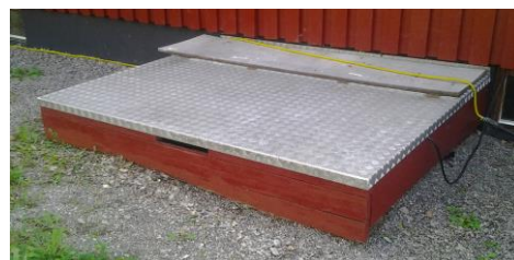
Nergrävt under marknivå.
